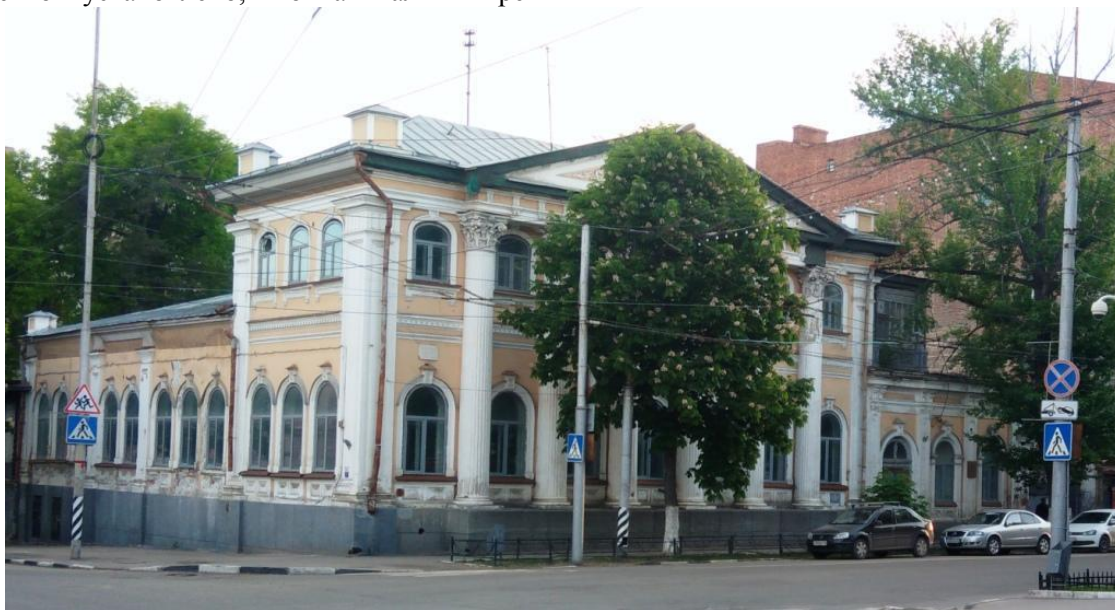
Рис. 1. Общий вид здания
